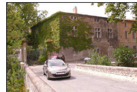
Photographie 10 : pont de Saint-Pons
