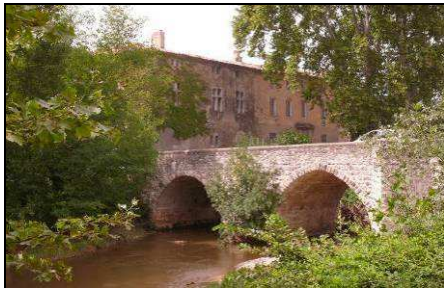
Photographie 49 : pont franchissant l'Arc à Saint-Pons
