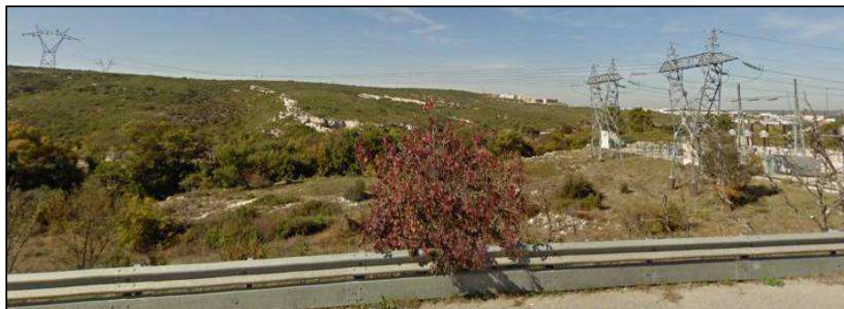
Photographie 54 : site perçu depuis la RD9, au niveau du poste électrique
