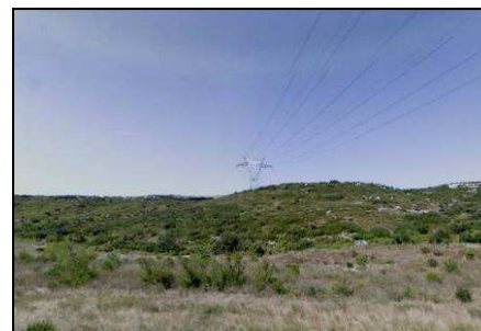
Photographie 42 : lignes électriques marquant le plateau central (vue depuis la RD543 au sud du site)
