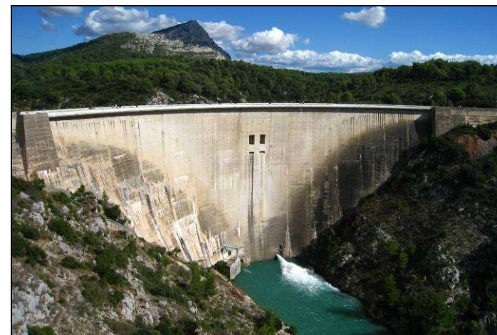
Photographie 3 : barrage de Bimont (13)
