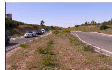
Photographie 6 : RD 543 vu depuis Lagremeuse
